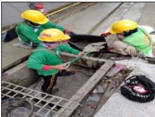
ภาพที่ 51 กิจกรรมขุดลอกตะกอนดิน
